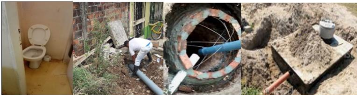
Excusado conectado a pozo ciego
